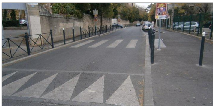
Photo 7 : Aménagement de passage piéton (source DA2T)
